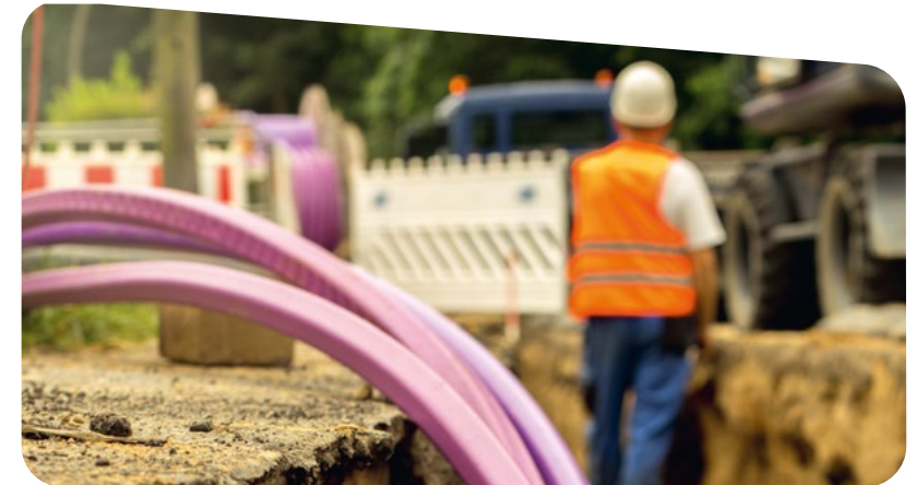
Kabel müssen für die sichere Stromversorgung in den Boden – damals wie heute.
